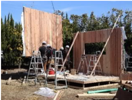
図 3 建設中の様子
