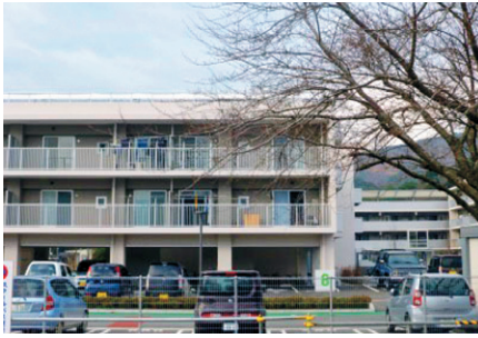
女川町運動公園住宅
