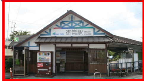
学生が修景した名鉄駅舎
