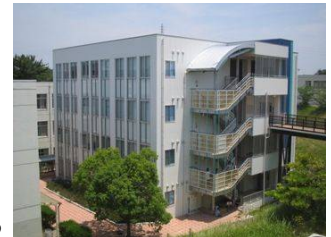
子ども発達実習棟(15号館)の外観
